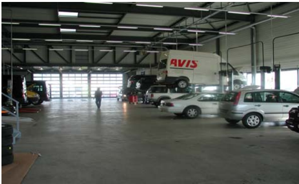
L'atelier mécanique au Rez
